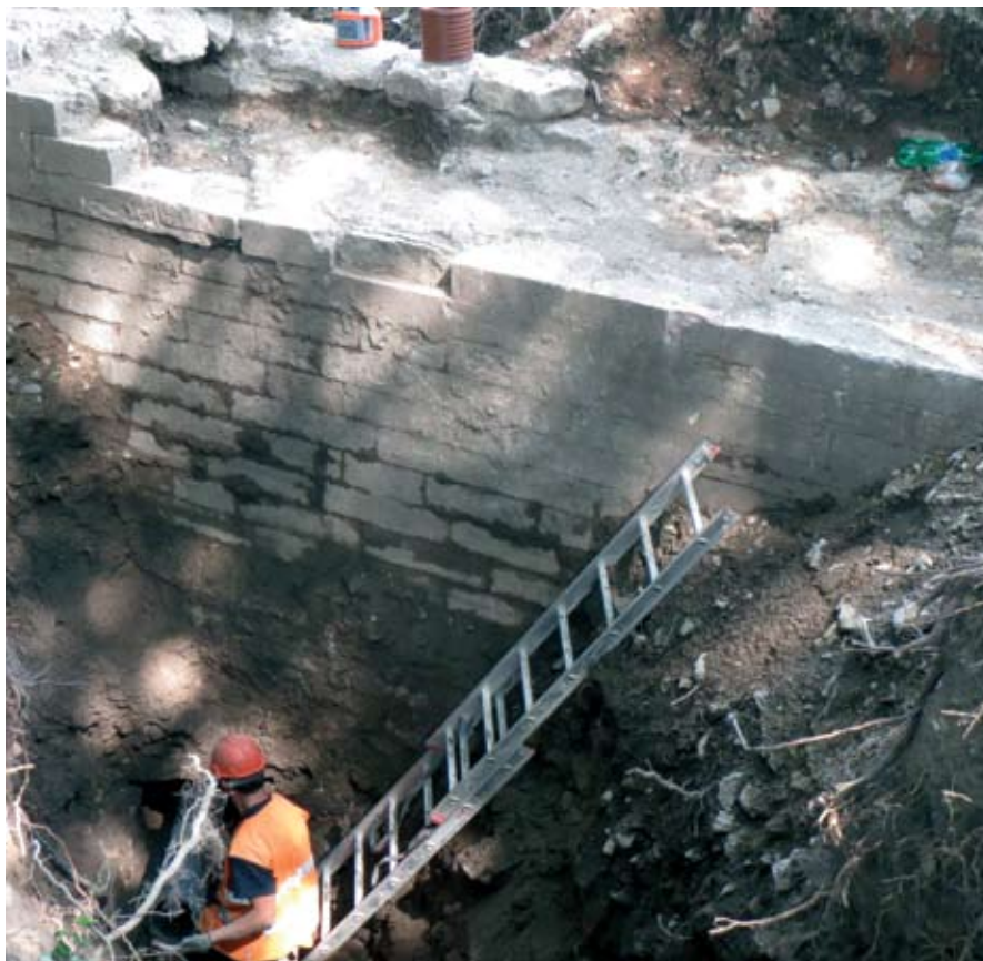
Arheoloogilise järelevalve all avatud osa Pax bastioni korrapäraselt tahatud lubjakiviplaatidega kaetud kirdepoolsest välismüürist. Foto: Aivar Kriiska.
